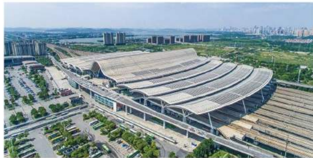
河东综合交通枢纽中心
